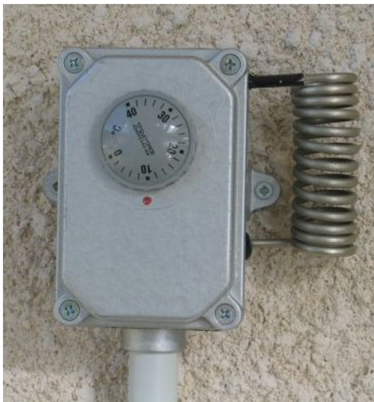
Thermostat indépendant utilisé dans la serre de Bernard GALLARDO
